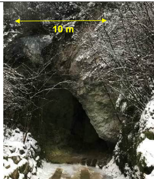
Figura 3: Fotografia dell'imbocco della galleria della cava Grassello
