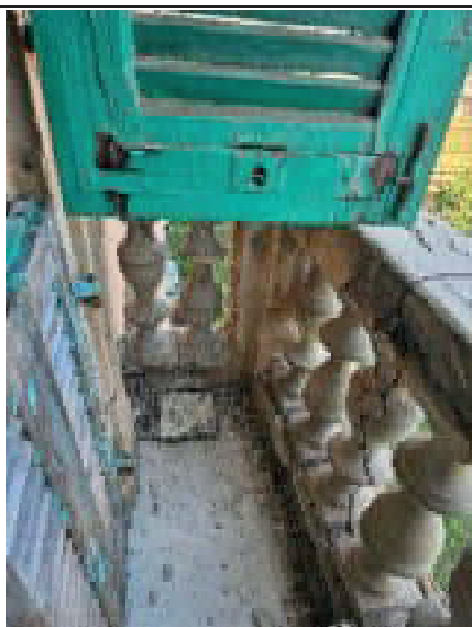
foto 27. Dettaglio balcone piano primo
