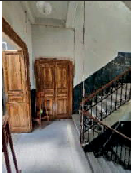
foto 71. Dettaglio vano scala
