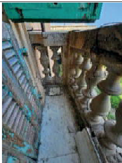
foto 28. Dettaglio balcone piano primo
