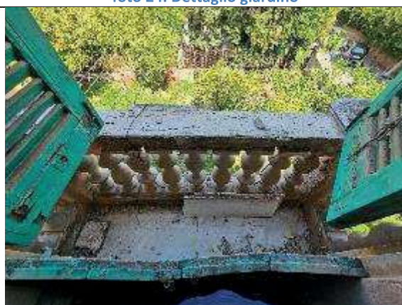
foto 26. Dettaglio balcone piano primo
