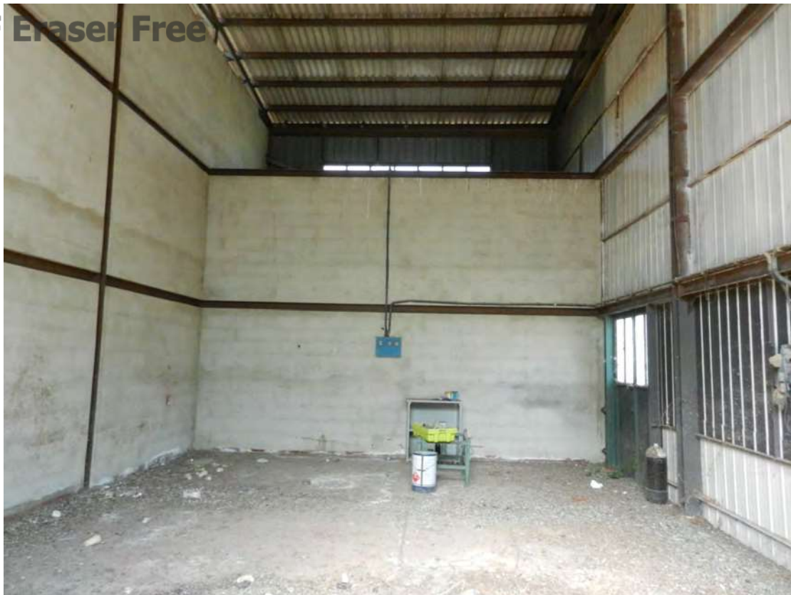
Foto 13 deposito fg. 18 - p.lla 201 NTC Fg. 7 p.lla 1121
