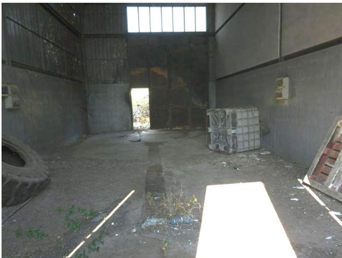
Foto 14 deposito fg. 18 - p.lla 201 NTC Fg. 7 p.lla 1121
