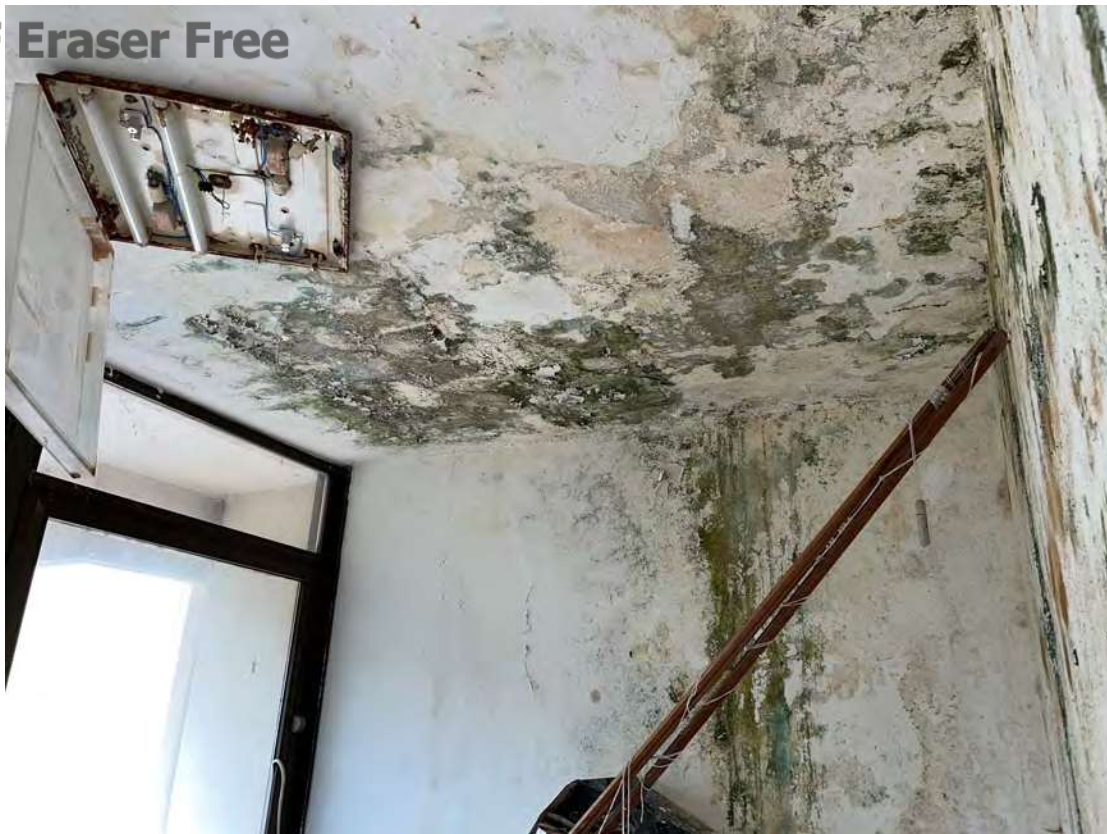
Foto 23 uffici P.T.-rialzato fg. 18 - p.lla 201 NTC Fg. 7 p.lla 1121 (infiltrazioni evidenti)
