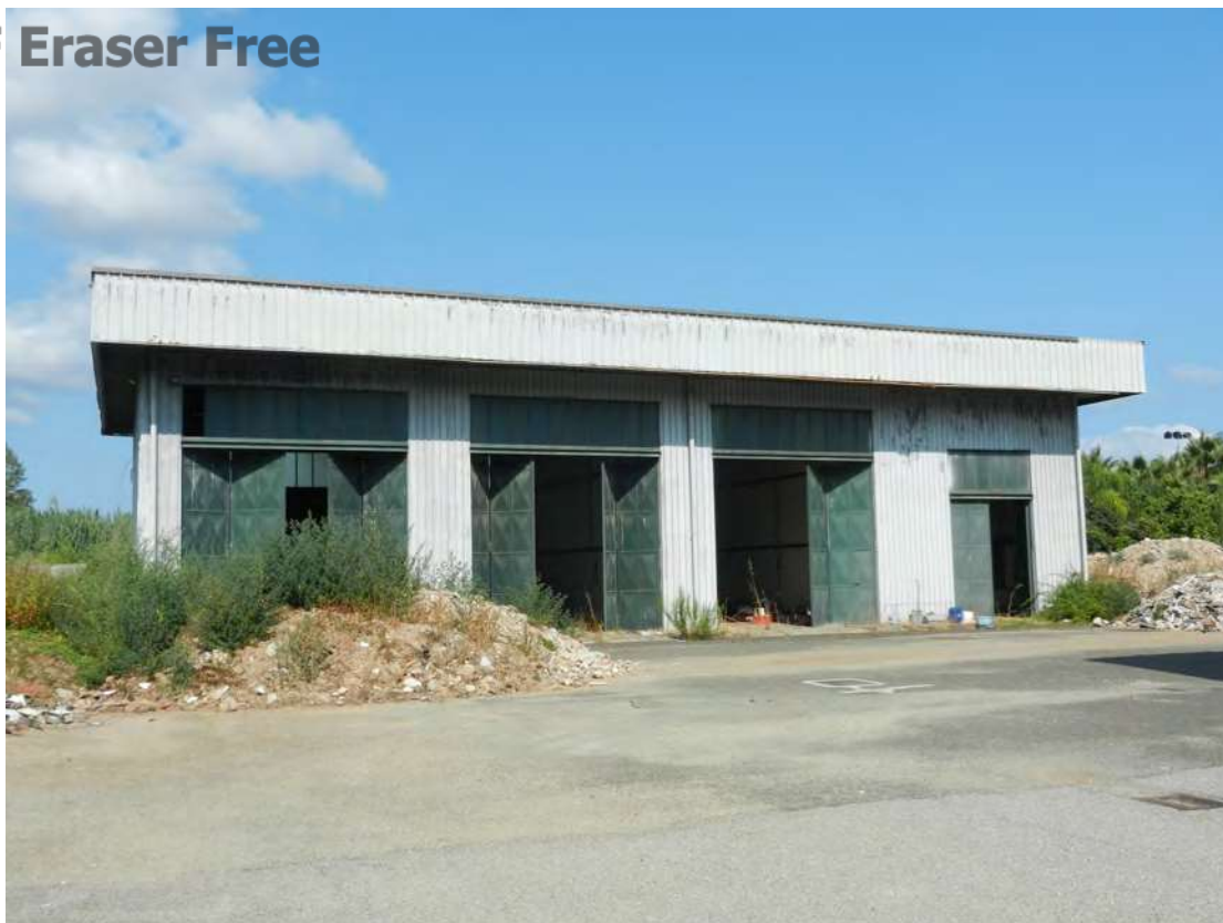
Foto 5 deposito fg. 18 - p.lla 201 NTC Fg. 7 p.lla 1121
