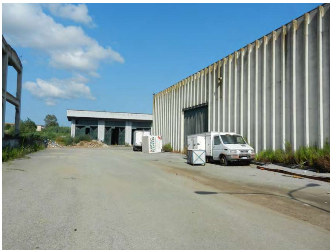
Foto 4 area interna-capannone-deposito fg. 18 p.lla 201 NCT Fg. 7 p.lla 1121
