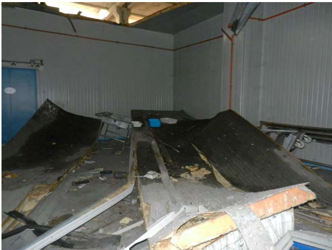
Foto 10 detriti copertura crollata fg. 18 - p.lla 201 NTC Fg. 7 p.lla 1121
