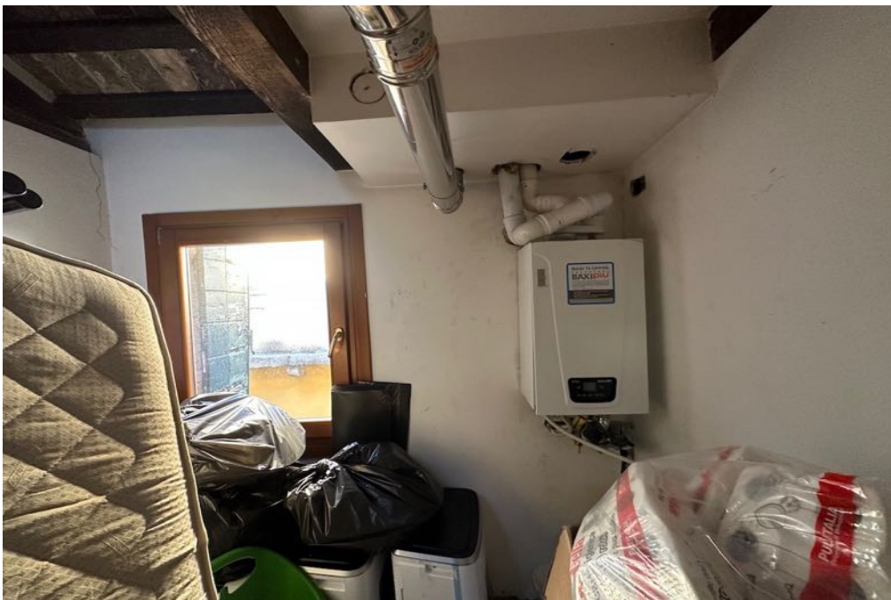
8. Piano terzo - Magazzino
