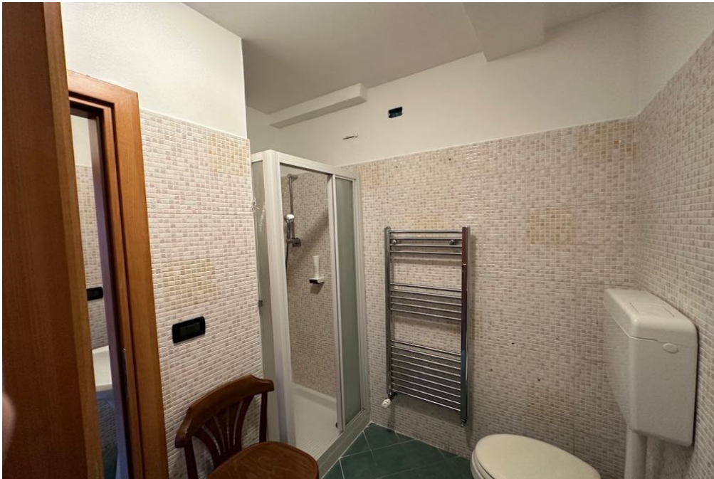
17. Piano terzo - Bagno 2
