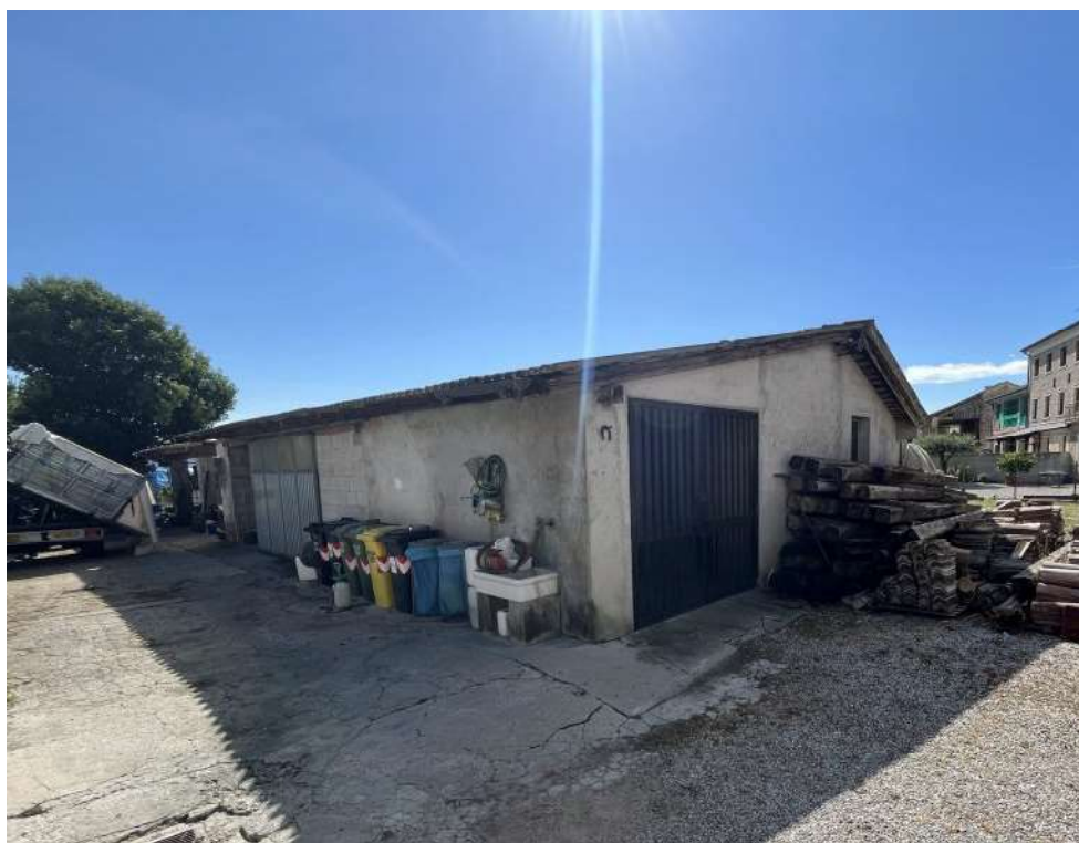
N.3 – Vista nord-est
