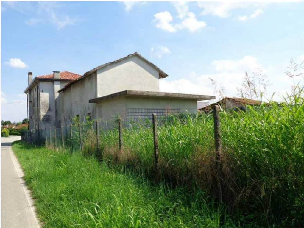
Foto n. 4: Il terreno da Via Bandi
