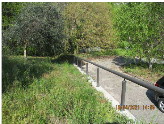
Strada privata interna che sale al fabbricato
