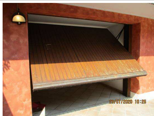
Particolare accesso al garage al piano S1
