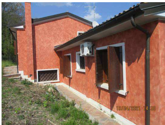
Prospetto Ovest vista da Sud
