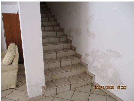
Vano scala di accesso al PT dal garage
