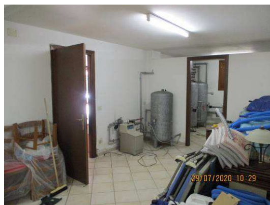
Ripostiglio con accesso da garage e accesso a cantina
