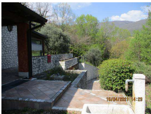
Accesso pedonale verso l'ingresso a sinistra
