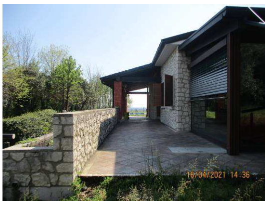
Prospetto Nord del lastrico solare e del portico
