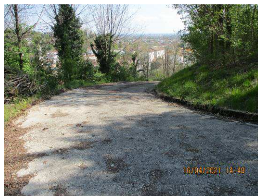
Strada privata interna che sale al fabbricato
