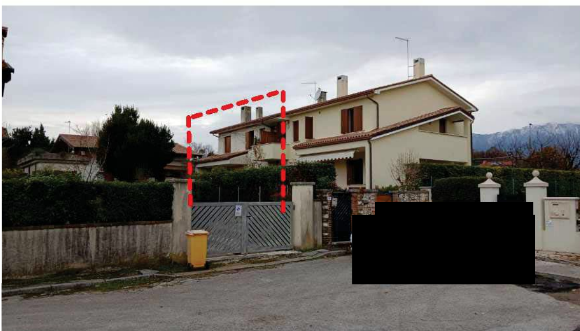
Vista da Sud/Est via Verdi
