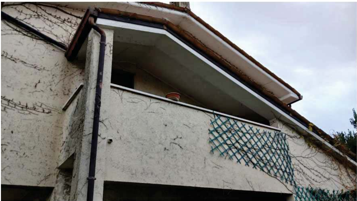
Vista prospetto Ovest
