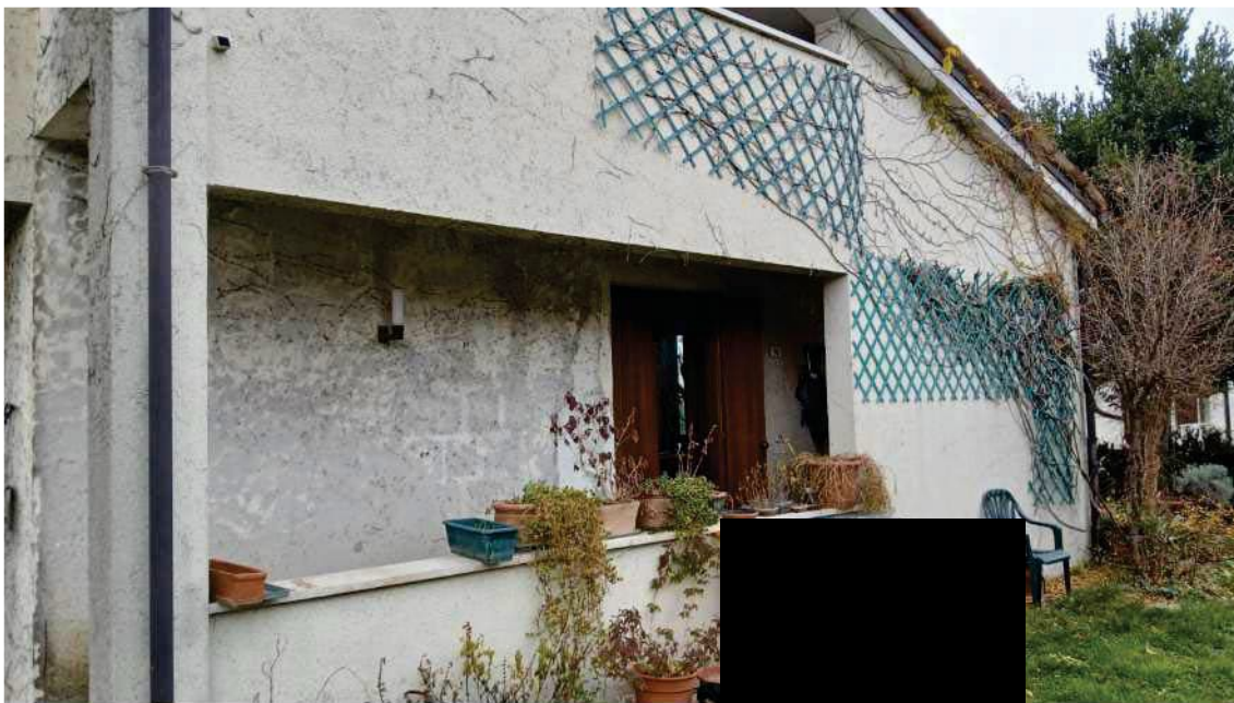
Vista prospetto Ovest
