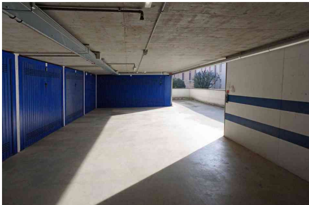
7. Piano primo, parte comune.
