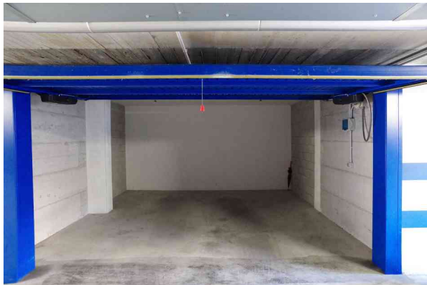
14. LOTTO 7, piano secondo - garage n. 44. Particella 173 sub. 54. (2 di 2).
